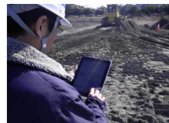
写真-3 iPad による施工管理
