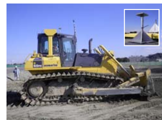
写真-1 GNSS システム搭載ブルドーザー
