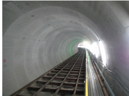
写真-3 一次覆工の仕上がり
