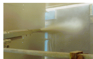
↑ 吹付け速度 12m 3 /h 吹付け厚 40cm →
