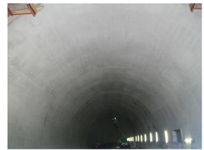
写真 6 表面の仕上がり
