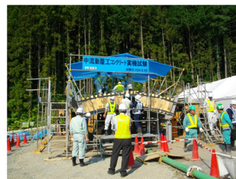
写真 7 実大モデルによる アーチ部打設試験
