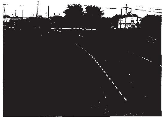
写真-7 曲線半径 100mの線形
