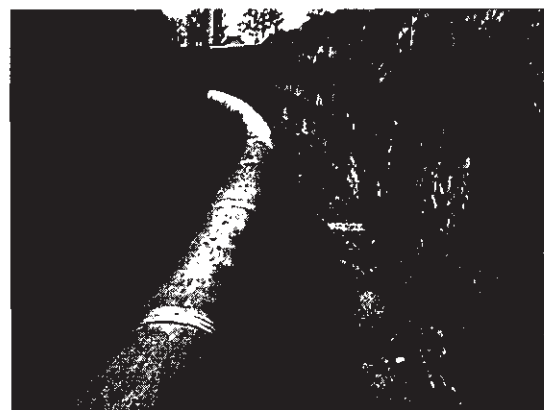
写真-10 開削による精度の確認
