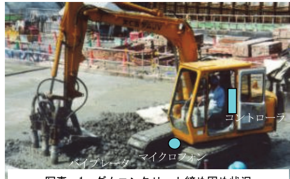
写真-1 ダムコンクリート締固め状況
