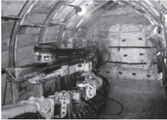
写真-3 スロット削孔状況
