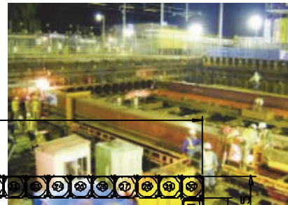
写真-2 箱形ルーフ施工状況
