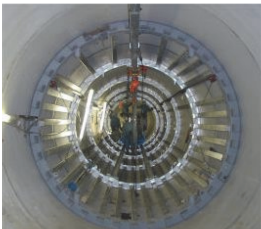
写真-2 ライニング材の接続（内径 3,000mm）
