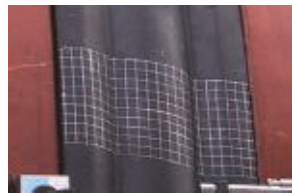
写真-7 変形状況
