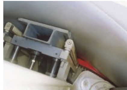
写真-1 新設防水シート固定装置
