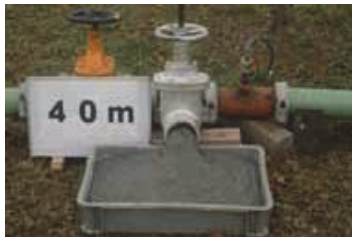
写真-4 排土状況 (圧送距離 40m 地点)
