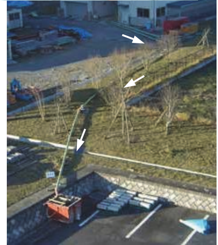
写真-3 搬送実験状況
