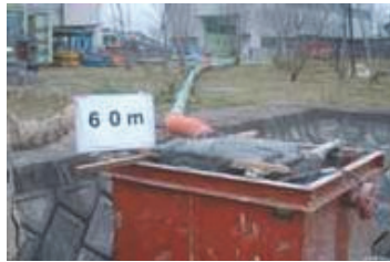
写真-5 排土状況 (圧送距離 60m 地点)
