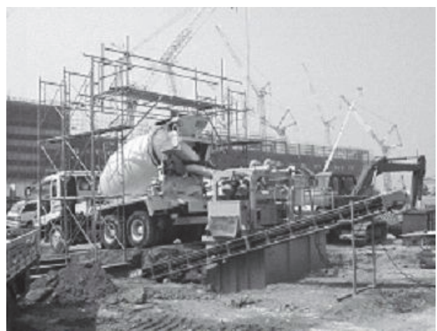
写真一 1 試験状況
