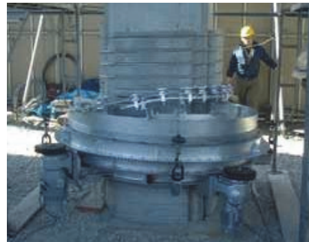
写真-1 スパイラル鋼線自動巻付機
