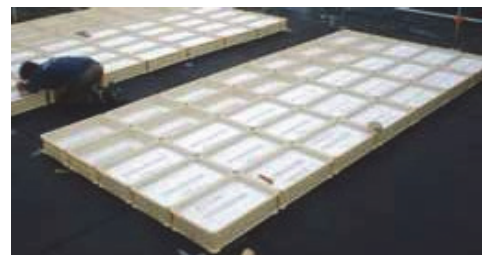
写真-1 緑化プランターの敷設状況
