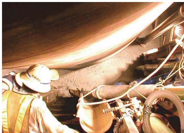
写真-2 コンクリート打設状況
