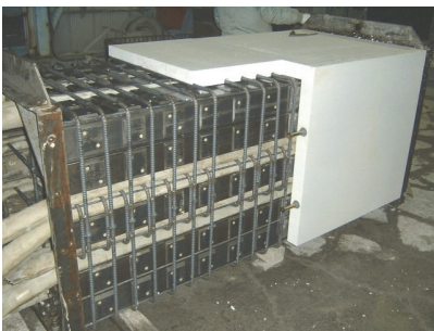
写真-6 流し込み内型枠状況
