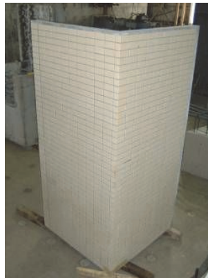
写真-11 流し込み成形 出来形[外壁面]
