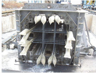
写真-7 流し込み型枠状況
