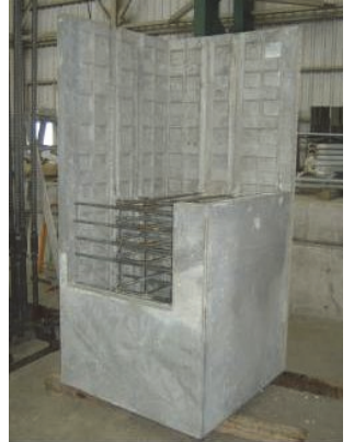
写真-12 流し込み成形 出来形[内面]
