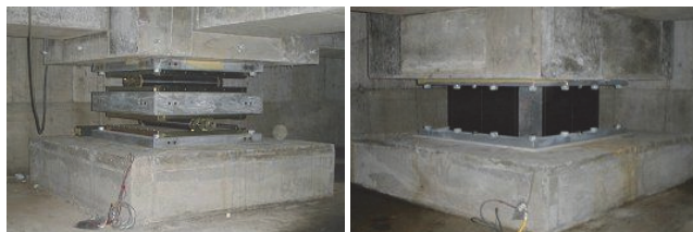
金属製転がり支承 (CRB) 鉛入り積層ゴム (LRB)
