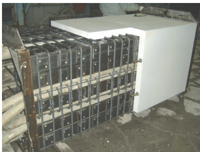
写真-6 流し込み内型枠状況
