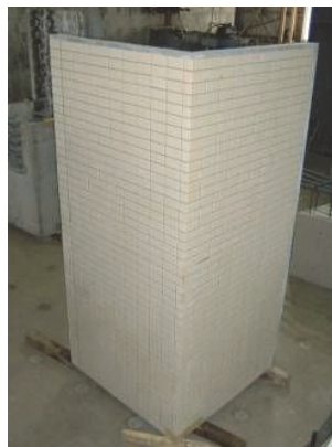
写真-11 流し込み成形 出来形[外壁面]
