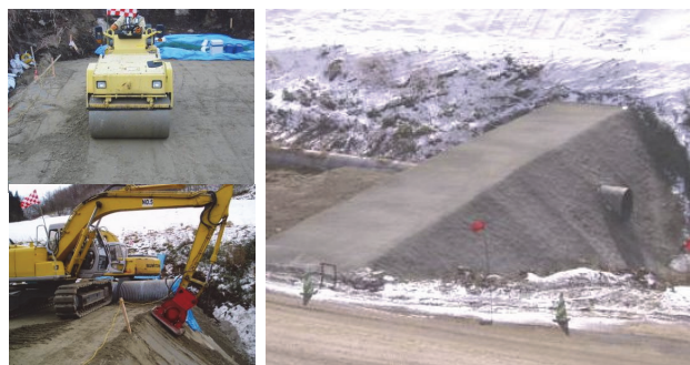
写真-4 転圧状況
