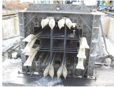
写真-7 流し込み型枠状況
