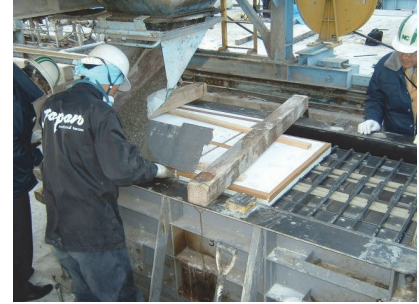
写真-8 流し込み打設状況
