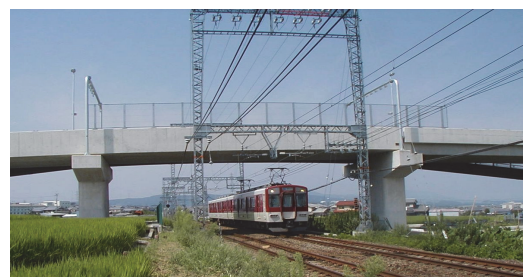
写真二 床版防水の施工スパン
