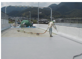
写真-3 ライニング状況
