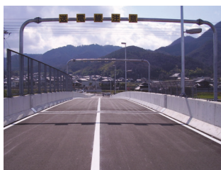
写真-4 舗装完了
