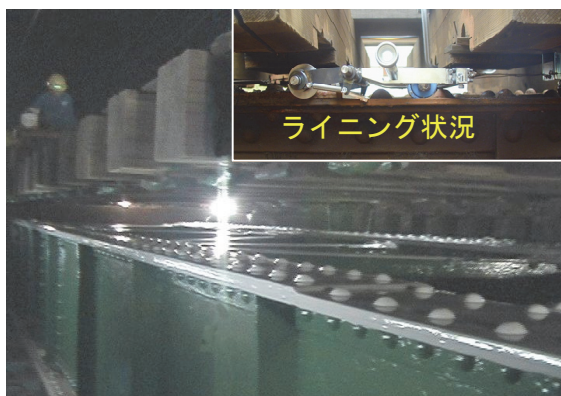
写真-8 桁上ライニング完了状況
