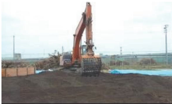
写真-1 C重油系汚染土壌の微生物処理状況
