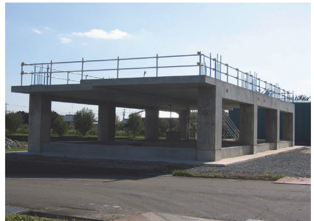
写真-1 実大試験体写真
