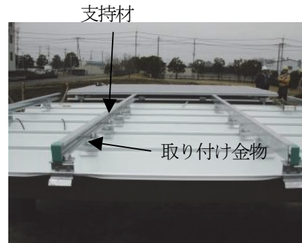
図-4、写真-3 取り付け金物、支持材の設置
