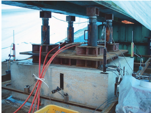
写真-1 載荷試験状況
