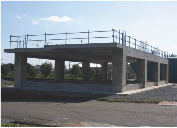
写真-1 試験スラブの全景
