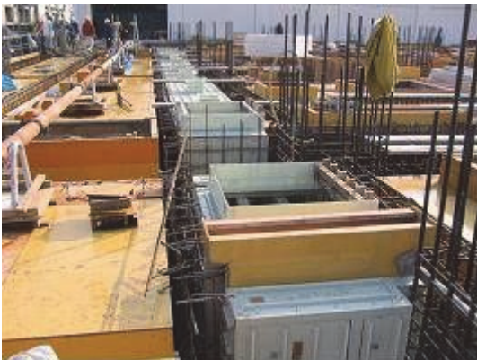
写真－8 箱抜き・段差部
