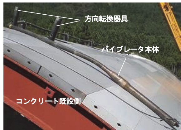
写真-4 バイブレータの方向転換状況
