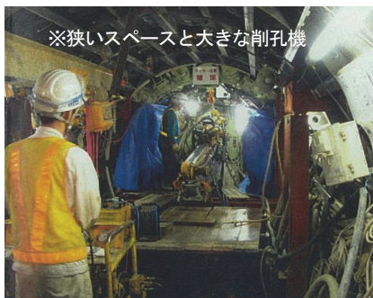
写真-7 削孔状況写真
