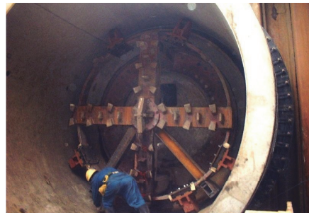
写真-3 坑内引戻し状況(実績No.3)
