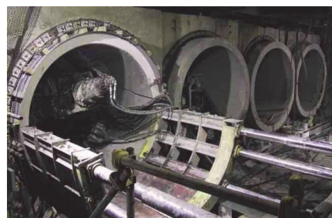
写真-1 4連換気坑の施工状況（実績No.1）
