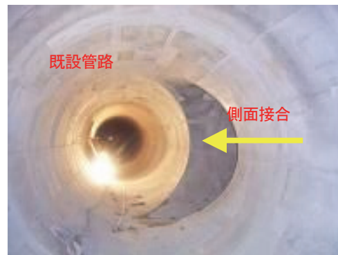
写真-6 側面接合完了状況 (実績No.8)
