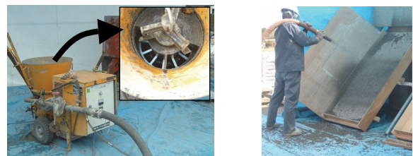
写真-7 小型リボルバー式吹付け機と吹付け状況
