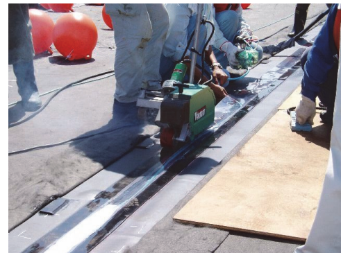
写真-2 複合シート接合状況
