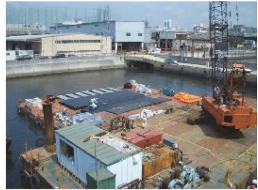
写真-1 接合台船の艀装状況
