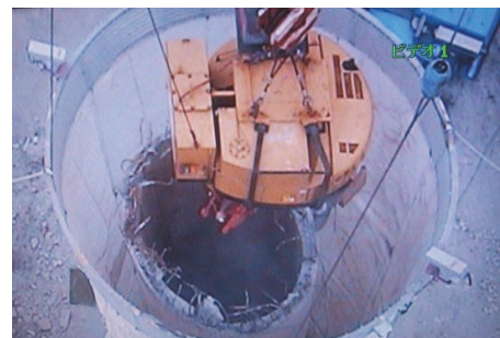
写真-8 コンクリート破砕状況
