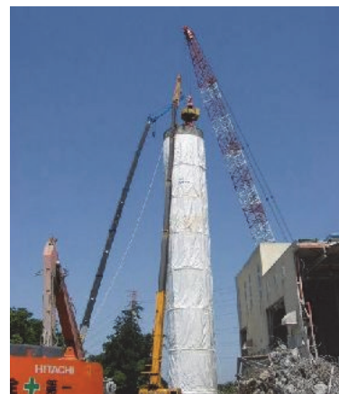
写真-4 飛散抑制シート設置完了状況 (クレーン：150t クローラー×1台、45t ラフター×2台)
