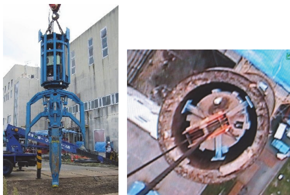
写真-9 レンガ解体機および解体状況
