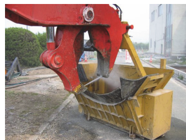
写真-5 高圧水噴射状況
