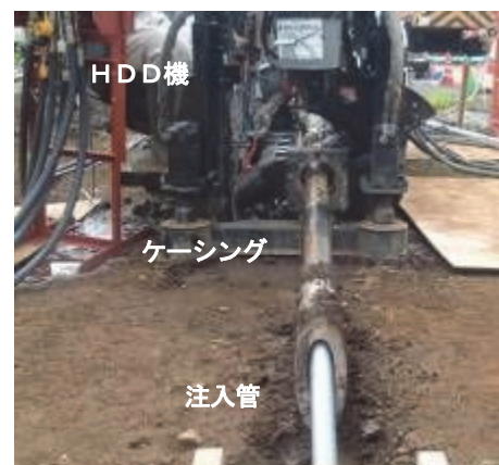
写真-1 注入管の置換え状況
