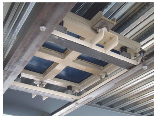
写真-3 横架材上に設置した TMD
