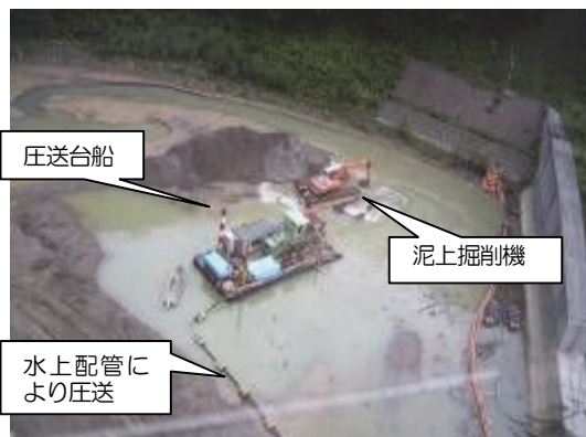
写真-2 泥上掘削機による浚渫作業状況
