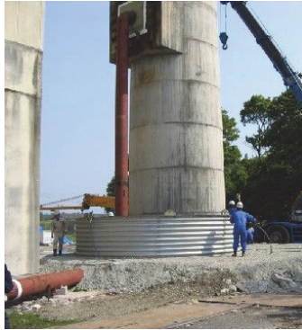
写真-7 集塵機配管状況
