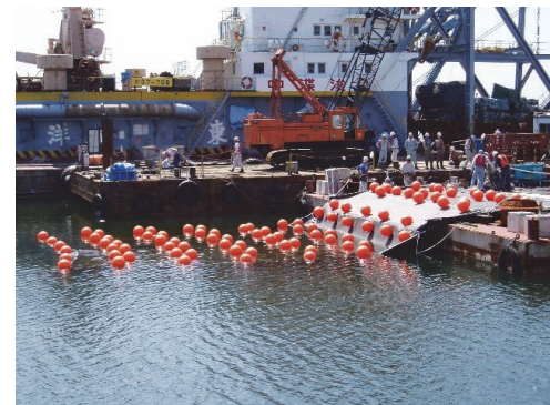
写真－3 引き出し状況
