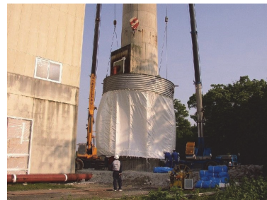
写真-3 飛散抑制シート組立状況
