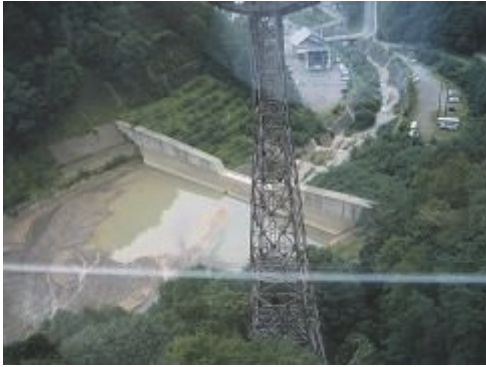
写真-1 工事着手前の堆積状況
