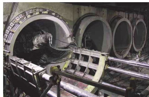
写真-1 4連換気坑の施工状況（実績No.1）
