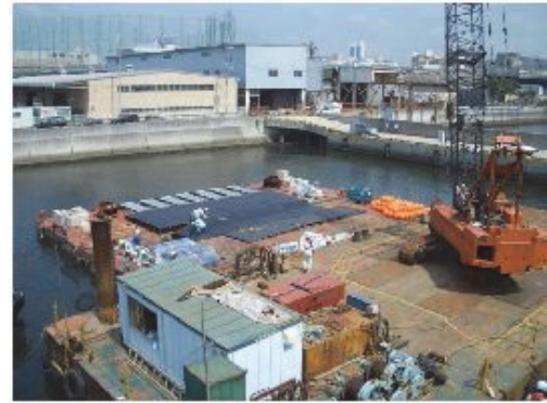
写真－1 接合台船の艀装状況
