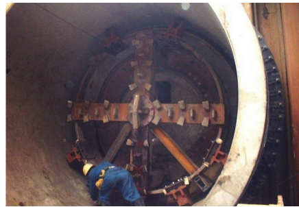
写真-3 坑内引戻し状況(実績No.3)
