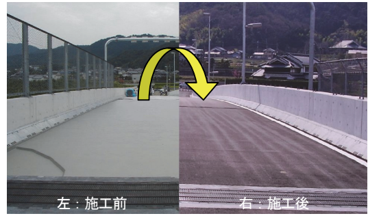
写真-2 新設跨線橋での事例
