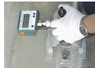
写真-5 付着性試験状況
