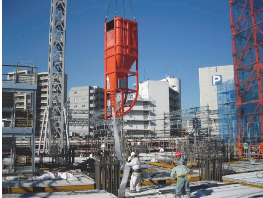
写真-2 コンクリートバケットによる打設状況
