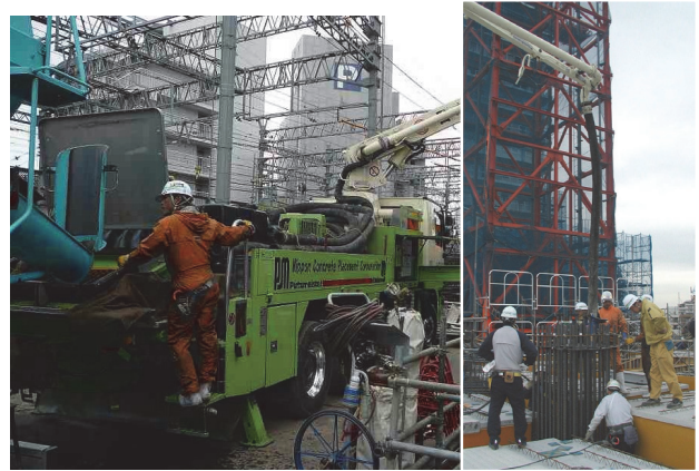
写真-3 ポンプ車による打設状況
