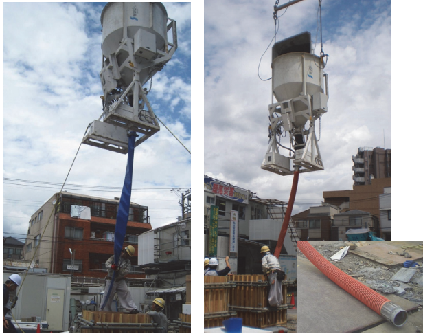
写真-2 バケツ打設状況
