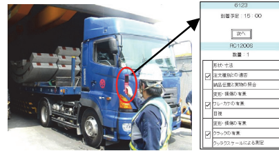
図-11 携帯による受入検査状況
