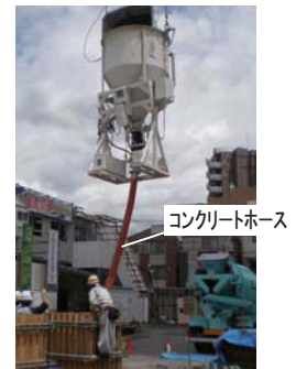
写真 1 バケット打設実験の状況
