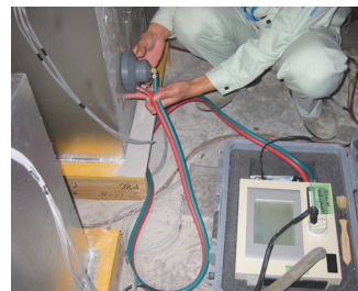
写真-3 表面透気試験状況
