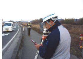
写真-4 路面沈下計測状況
