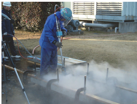
写真-5 ハンドガンによる試験施工
