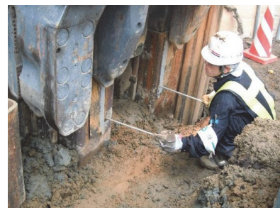
写真-5 角度補正プレートのセット
