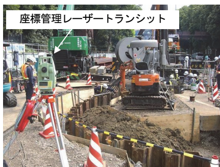
写真-2 測量管理状況
