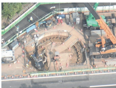
写真-3 円形打設状況（上空写真）
