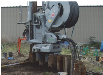
写真-1 鋼矢板の円形打設
