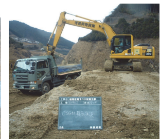
写真-8 CSG材の積込み
