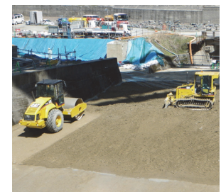
写真-12 敷均し・転圧
