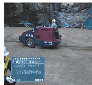
写真-9 打設前清掃
