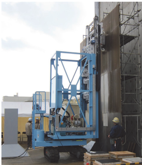
写真-2 施工性能試験状況
