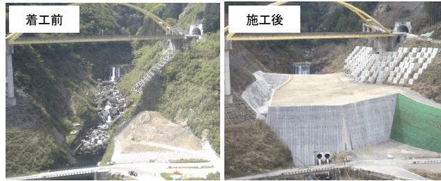
写真-2 施工場所
