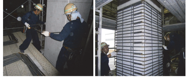
写真-1 普通鉄筋の組立状況
