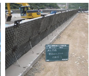
写真-14 残存型枠の設置
