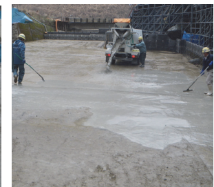
写真-10 打継面処理
