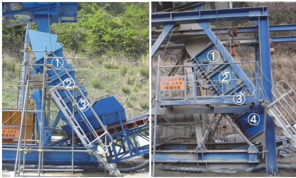
写真-16 3連式および4連式混合装置
