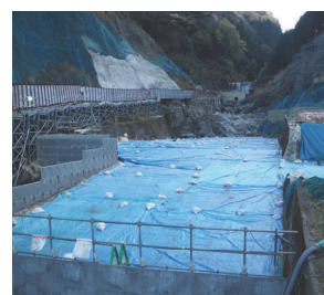
写真-13 打設面の養生
