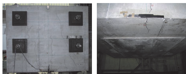
(a) 長手方向の側面 (b) 既設柱のすべり状況 写真-2 実験後の状況 (No.1-700X, No.1-700X-T)
