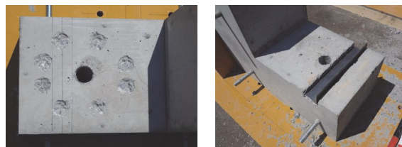
写真-1 接合面の状況
