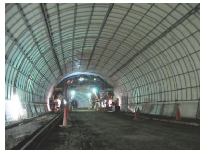
写真-1 養生台車の設置状況
