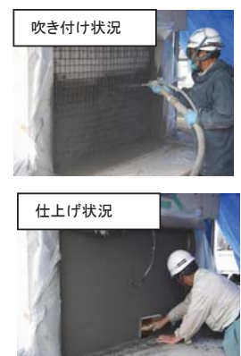
写真-1 吹き付けおよび仕上げ状況
