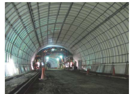
写真-1 養生台車の設置状況
