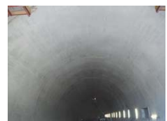
写真-2 仕上がり
