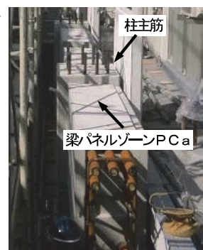
写真-11 梁パネルゾーン PCa の据付完了
