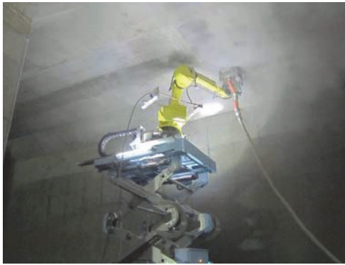
写真-6 施工状況（研掃）
