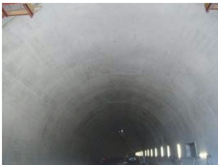
写真-7 覆工表面の仕上がり
