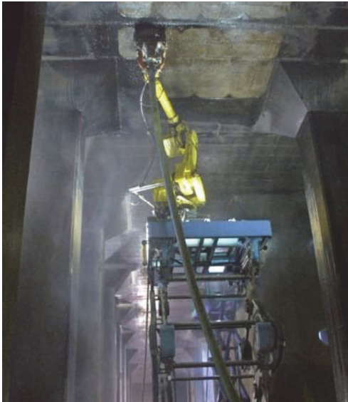
写真-7 施工状況（塗膜除去）
