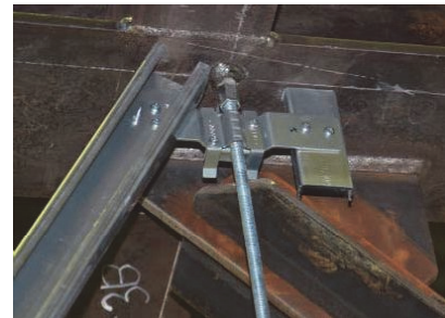
写真-5 ブレース上部 (改良)
