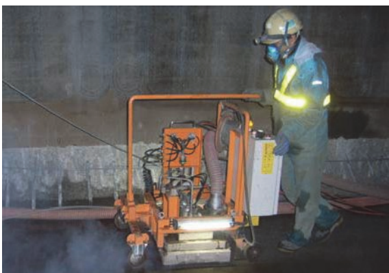
写真-9 施工状況（塗膜除去）
