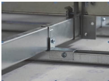
写真-3 クリップ補強金物
