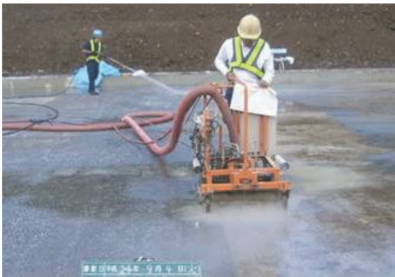
写真-8 施工状況（研掃）
