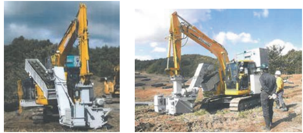
写真-6 葛尾村仮置場工事における施工状況
