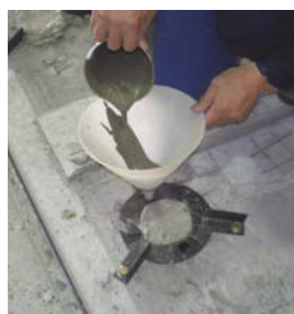
写真-1 グラウト充填状況
