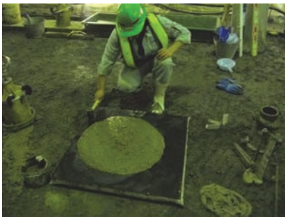
写真-4 日常管理試験（スランプフロー）
