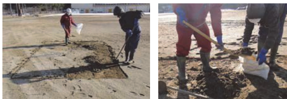
写真-2 汚染土壌（表土）採取状況
