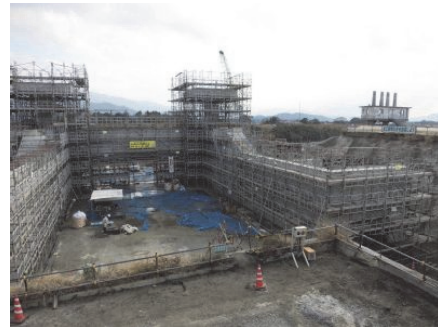
写真-1 水門の堰柱・門柱の施工時の外観
