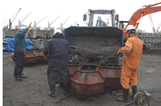
写真-2 打設状況
