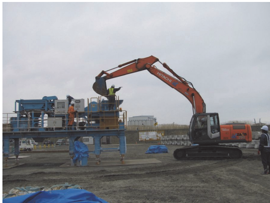
写真-1 材料投入状況
