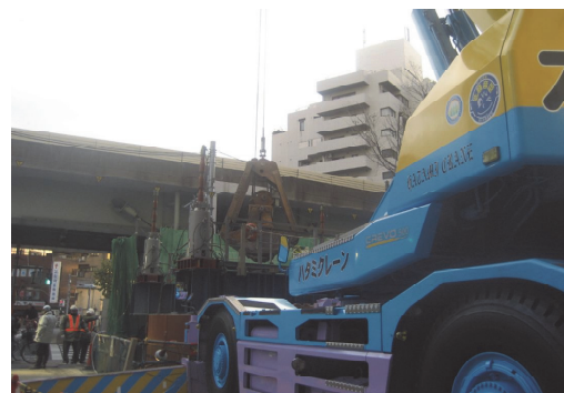
写真-2 立坑掘削工事状況
