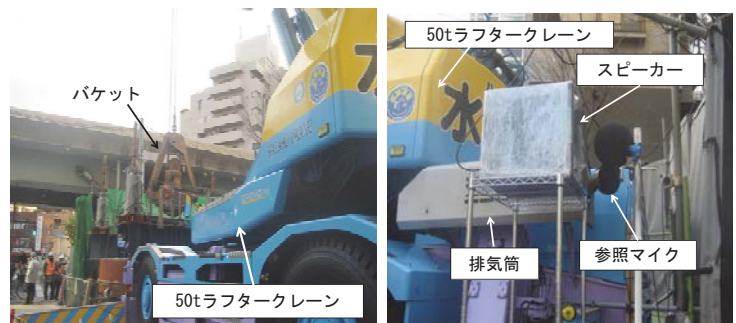
写真－1 立坑掘削工事状況
