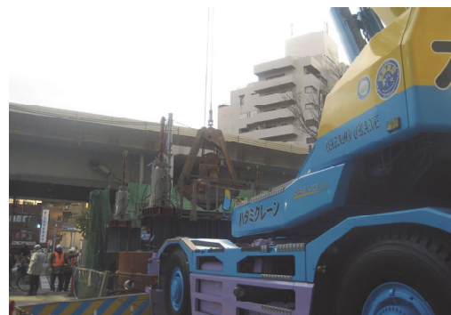
写真-2 立坑掘削工事状況
