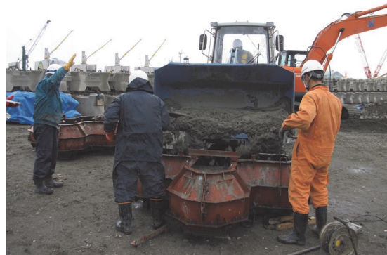
写真-2 打設状況
