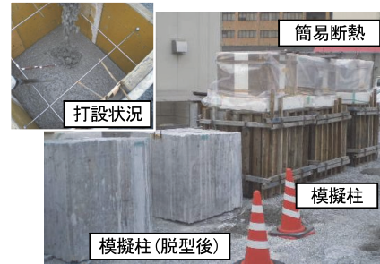
写真-2 模擬柱の打設および養生状況
