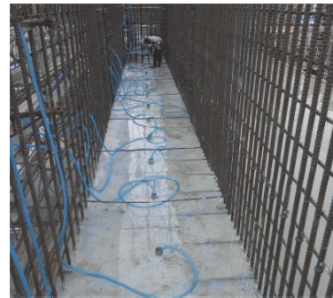
写真-2 鉛直パイプクーリング状況
