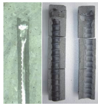
写真-7 上向き後施工の切断・割裂面
